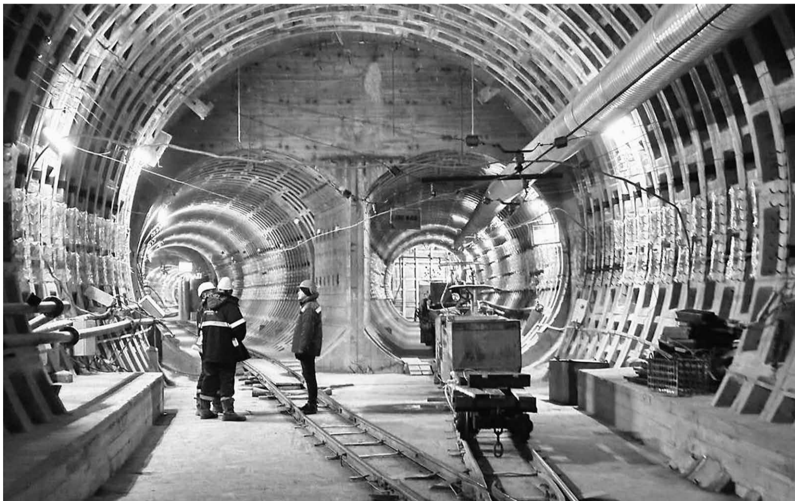
Для строительства новых линий и станций «Метрострою Северной столицы» требуется дополнительное оборудование /Т.МЕ/STROIIMMETRO
